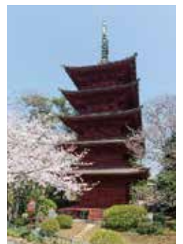
五重之塔(国指定重要文化財) 加賀前田家3代当主 前田利常公 寄進
